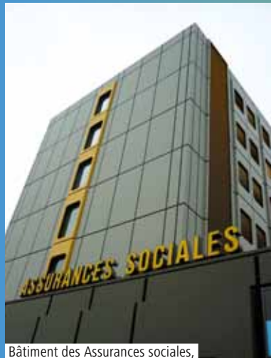
Bâtiment des Assurances sociales, Luxembourg 2010
